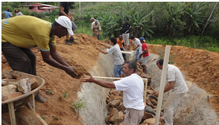
Figura 2: Mutirão de construção do tanque de evapotranspiração na residência de agricultor.
